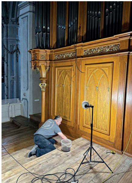
Prace konserwatorskie przy drewnianych schodach do miechowni w katedrze łańciskiej
