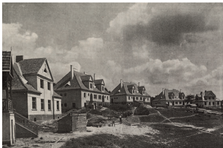
Widok ogólny na kolonię urzędniczą w Brześciu nad Bugiem
