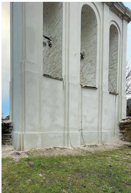
Konserwacja murów dzwonnicy kościoła w Mikulińcach
