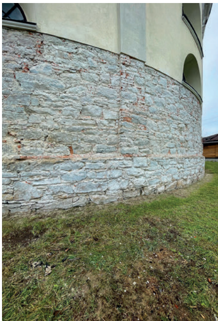
Mury kościoła w Mikulińcach po pracach konserwatorskich
