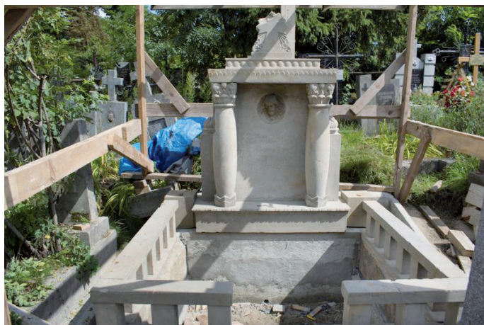
Lwów, prace konserwatorskie przy grobie Marii Rozdołowej
