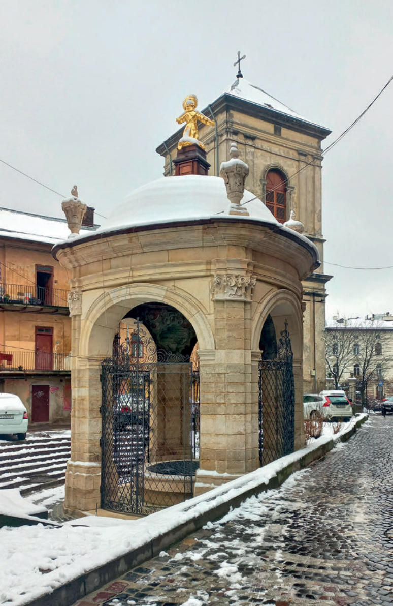
Lwów, studnia św. Jana z Dukli po zakończeniu prac konserwatorskich
