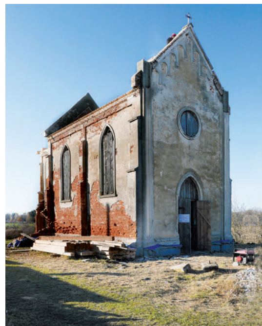
Hruszów, prace restauratorskie przy ścianach kościoła pw. św. Józefa
