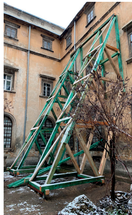
Konstrukcja zabezpieczająca ścianę Centralnego Państwowego Archiwum Historycznego Ukrainy od strony dziedzińca
