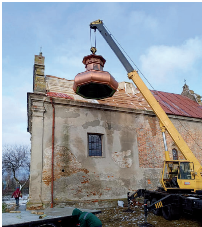
Luboml, prace konserwatorskie przy kościele
